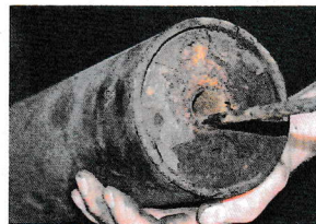
Ein neueres Problem: Vorne durchgerostete Federtöpfe
