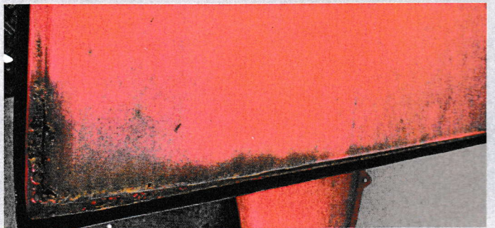
Bodenlos: Diese Türunterkante hat schon bessere Tage gesehen – sie müssen aber schon ein wenig länger her sein...
